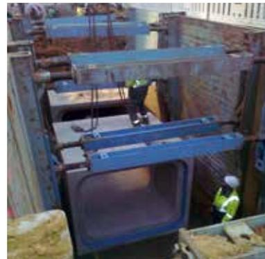
Eine Spezialität: die Verlegung begehbaren Kanäle, hier ein Kabelkanal, mit den Abmessungen von zwei bis zweieinhalb Metern.
